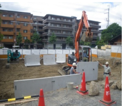
L字型コンクリート補強 (9月2日)
