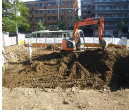
土削作業 (8月31日)
