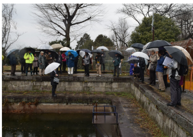
本願寺水道取水池
