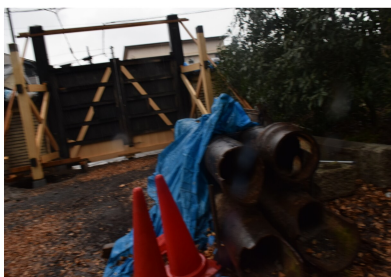
本願寺水道管
