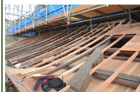
↑下層屋根瓦を載せる為の板張の工事中
