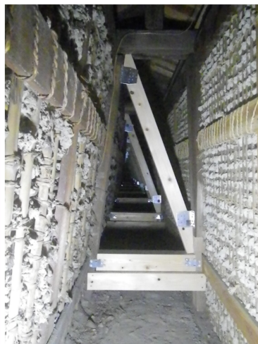
↑築地塀内部 築地塀内には築地塀の倒壊を防ぐため構造補強を施す工事が完了しました。
