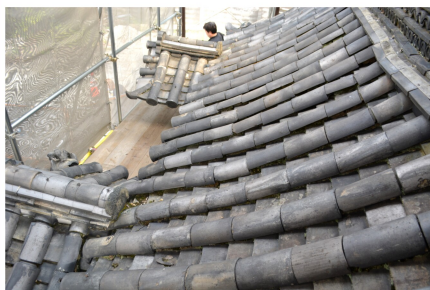
↑瓦が載っている山門修復前
