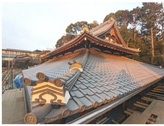
耐震強度補強、柱の根継ぎ補修、瓦総葺き替え、壁の塗り替え等の工事を終え、素屋根が解体されました。現在は本堂の内装工事を施工いただいております。掲載が素屋根解体後の本堂屋根になります。綺麗に瓦が整列され、以前より課題であった雨漏り等の心配も無く安心して参拝していただけるようになっております。
