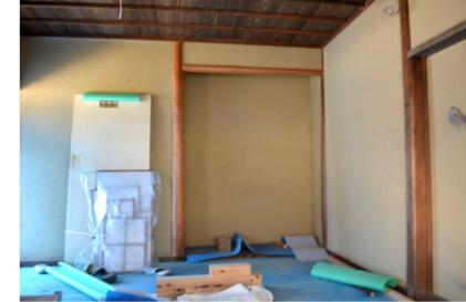
お茶室は、床下に冷暖房設備が設置され、新しい土壁の塗りが施されています。
