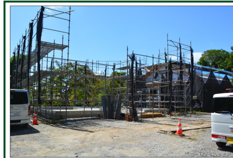
↑法要会館棟建て方工事準備の様子
