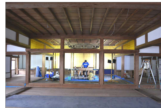
↑本堂内陣正面（内陣金紙貼りの様子）
