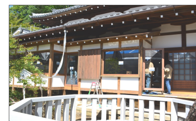
↑本堂建具の調整（西側より）
