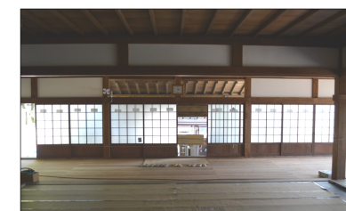
↑本堂建具（内部）
