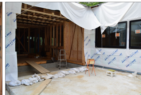
↑庫裏玄関部分の様子
