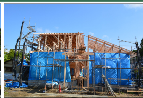
↑書院棟建て方工事の様子
