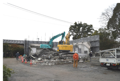
重機での学舎解体
