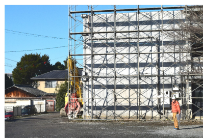
学舎解体前の囲い
