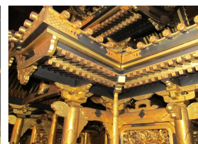
下屋根の継ぎ目
